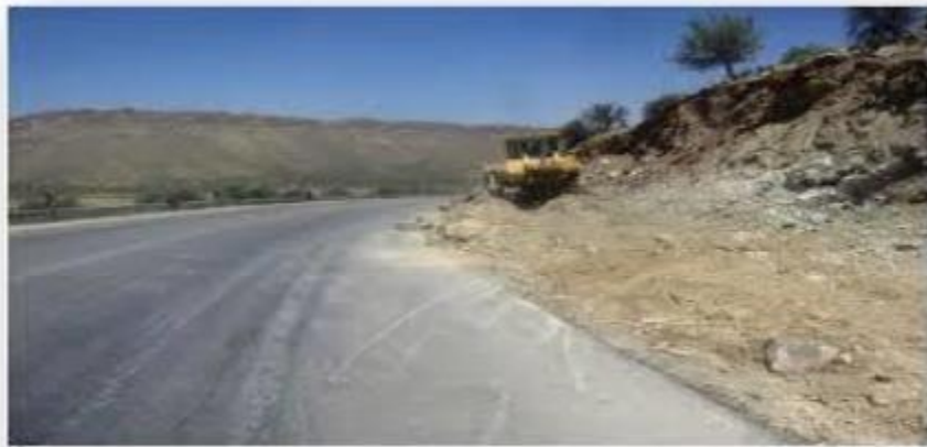
شکل ۱۳: نقطه حادثه خیز بین روستایی بدون خط کشی، تابلو و روشنایی
